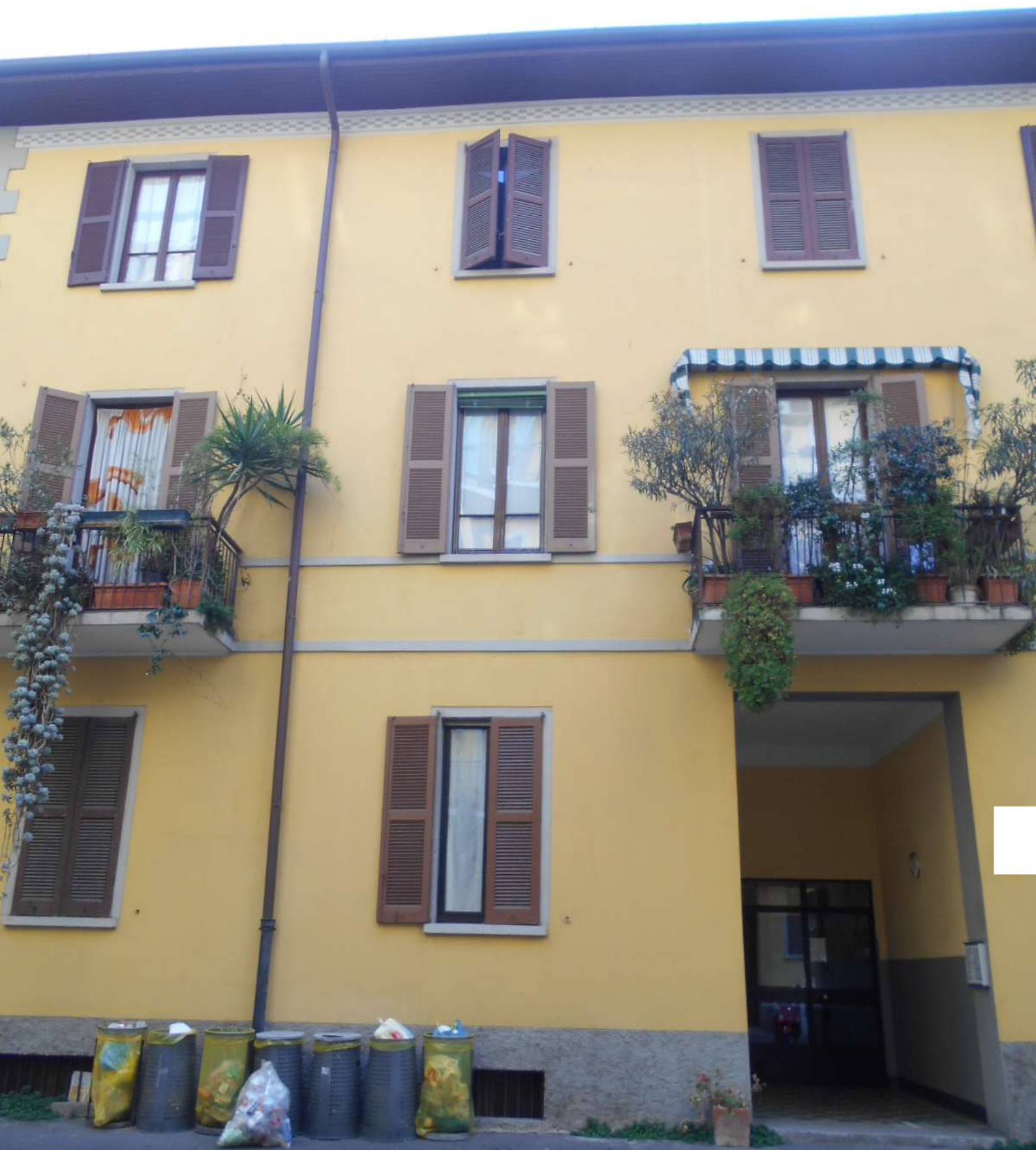
VISTA DA CORTILE
